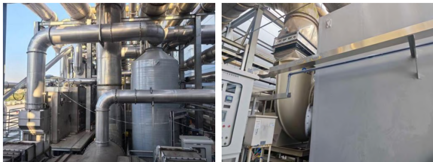
深圳华星半导体 VOCs 处理提效项目
