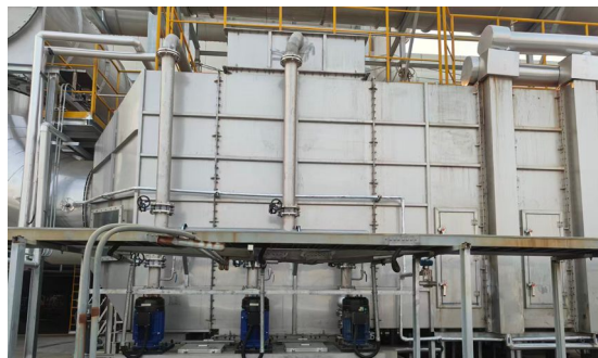
苏州华星开展废气提标升级改造项目
